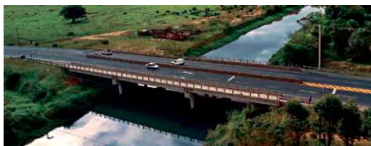
SÃO JOSÉ PONTE SOBRE O RIO FORQUILHAS
