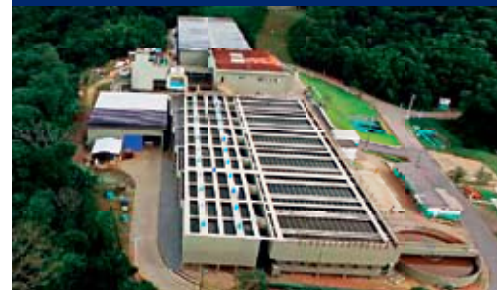
PALHOÇA ESTAÇÃO DE TRATAMENTO DE ÁGUA
