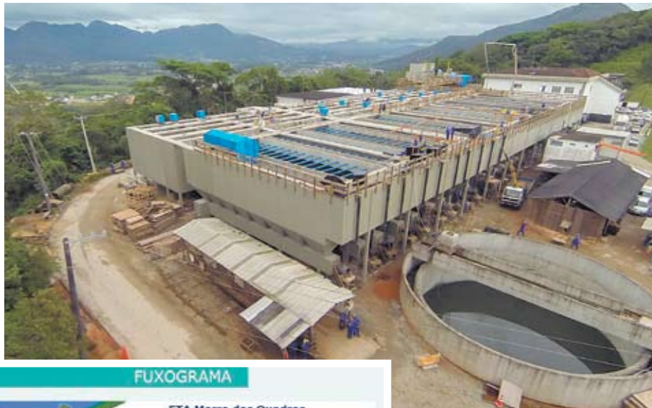
Sistema Flocodecantador: ampliação de 50% da capacidade de tratamento de água
